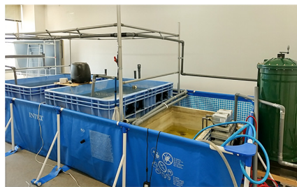
構築中の閉鎖式循環システム
